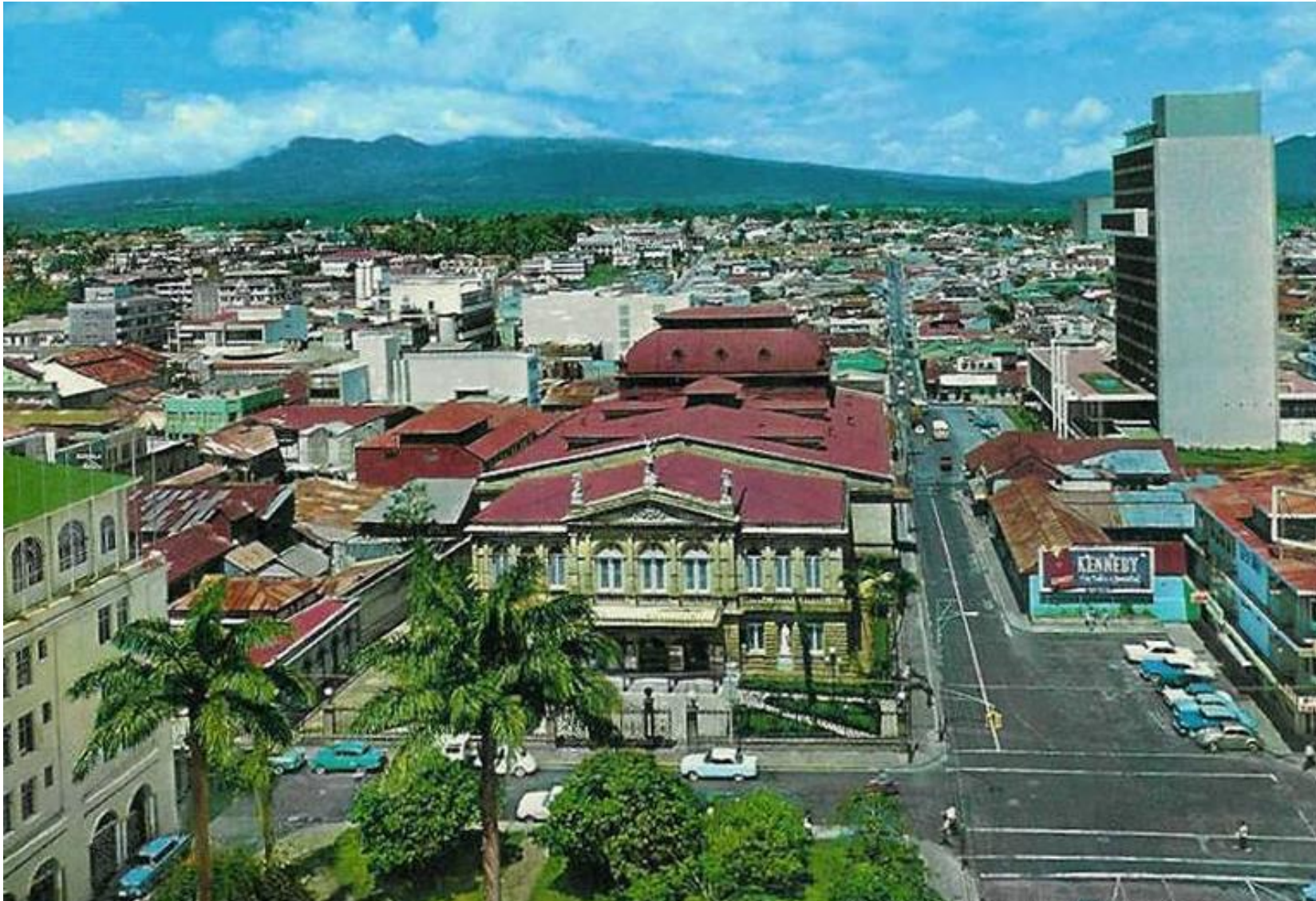
El Gran Hotel Costa Rica fue testigo de los sucesivos atrasos en la ampliación de la avenida 2ª.
