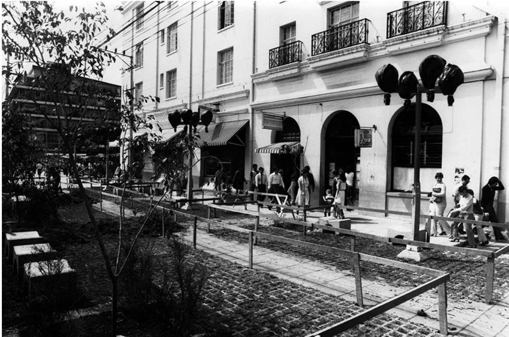
Parte de las obras de la Plaza de la Cultura, la calle 3 sur, entre avenidas Central y 2ª, se convierte en el primer tramo peatonalizado de la ciudad.
