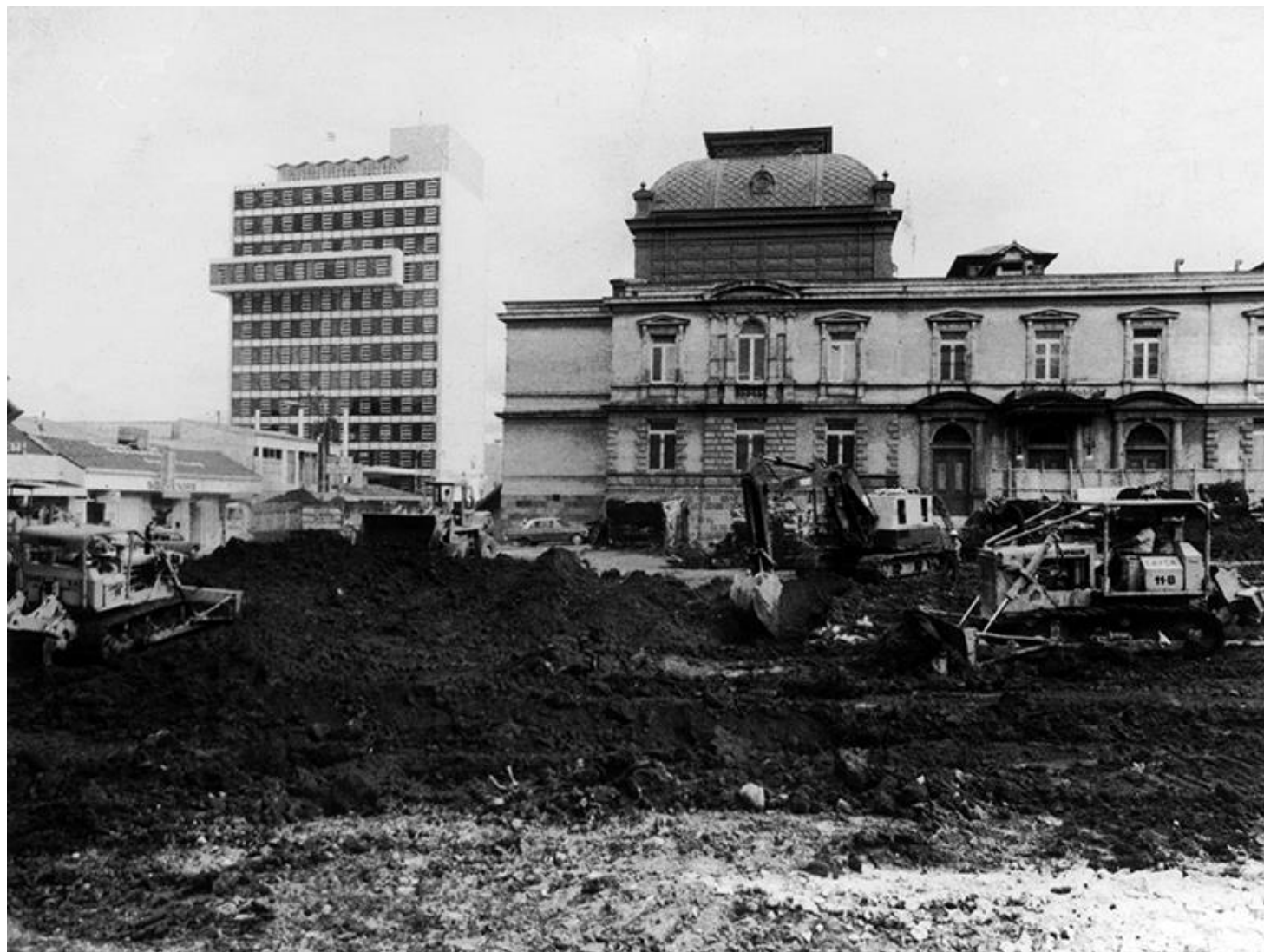
En 1977, dan inicio las obras de la Plaza de la Cultura, con la demolición de la media manzana al norte del Teatro Nacional.
