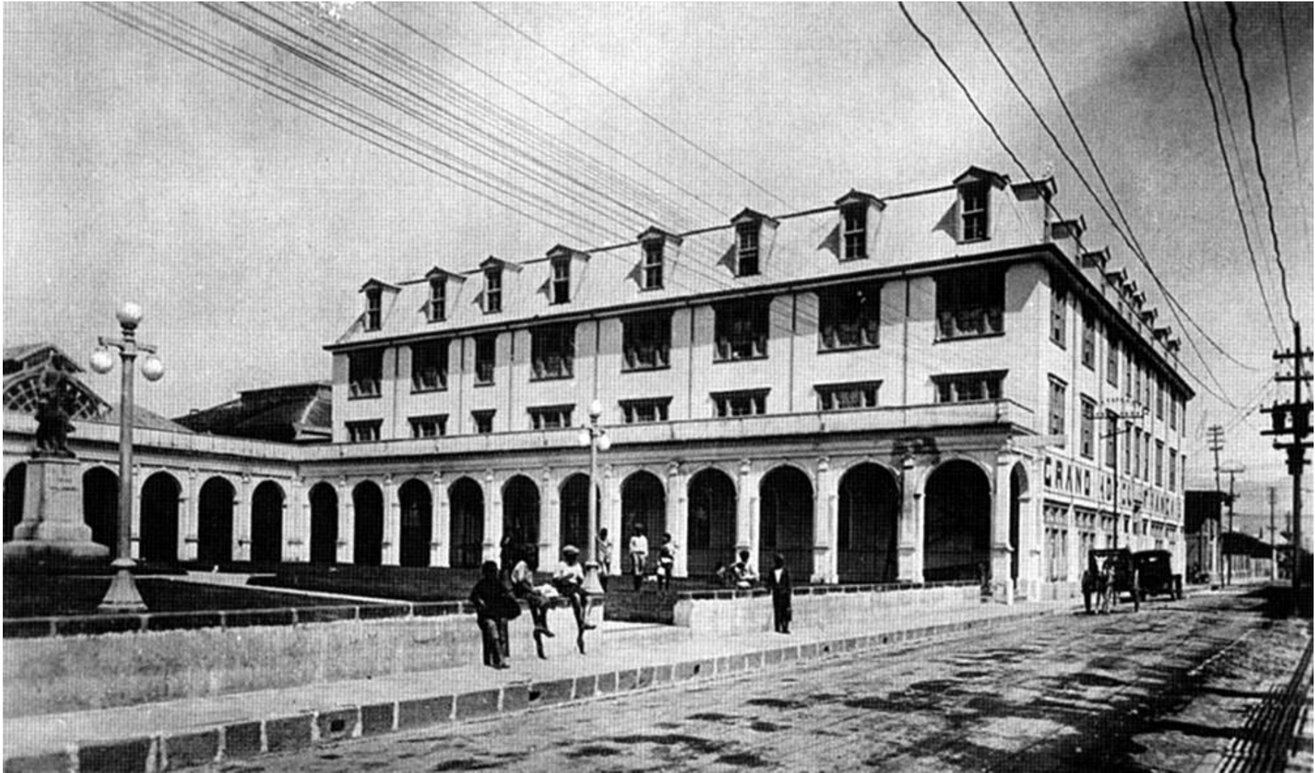
El Gran Hotel Francés en la década de 1920. Era una obra construida enteramente en madera.
