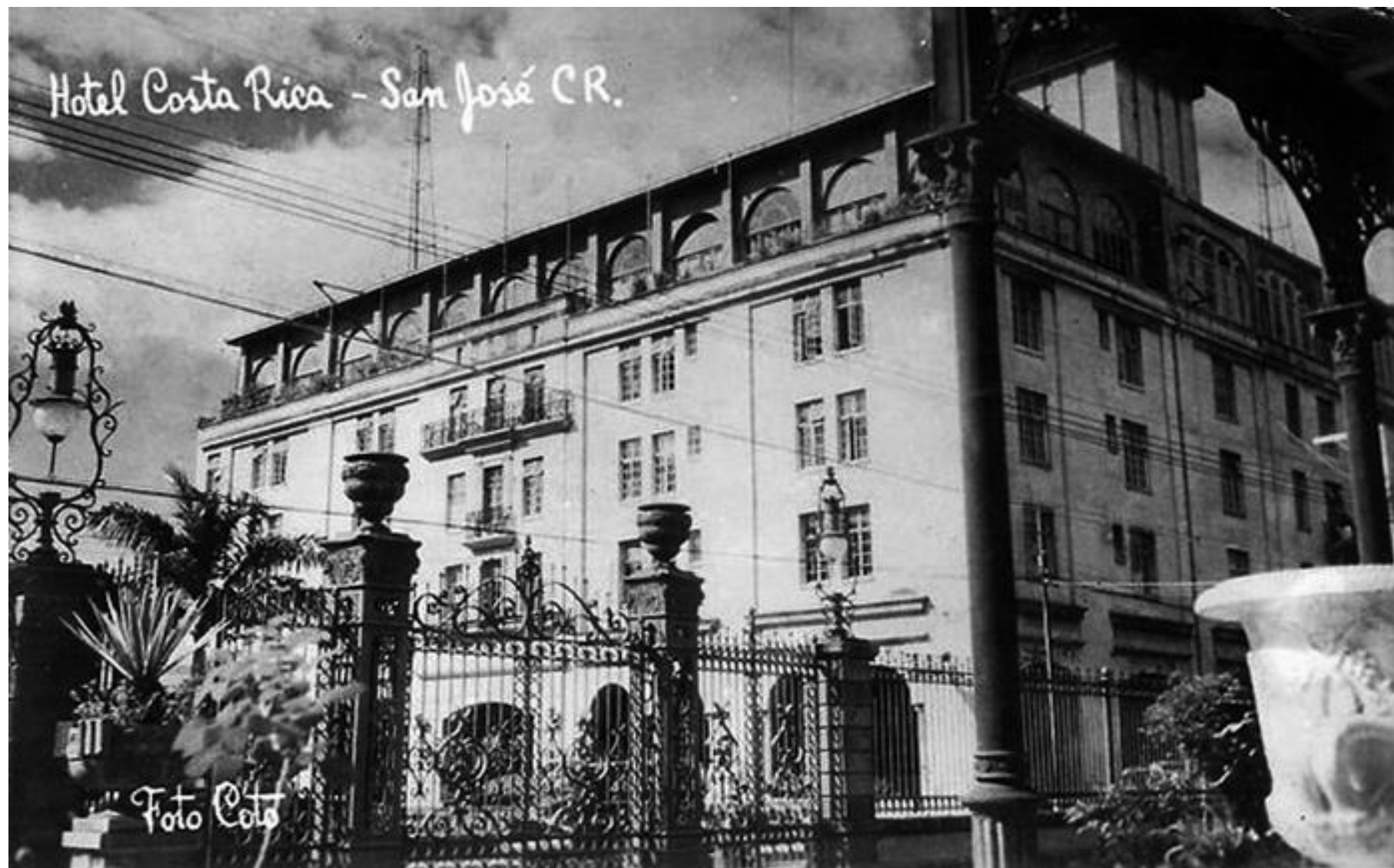
Una fotografía de los años 50 evidencia el crecimiento de dichas obras de ampliación del 5º piso.
