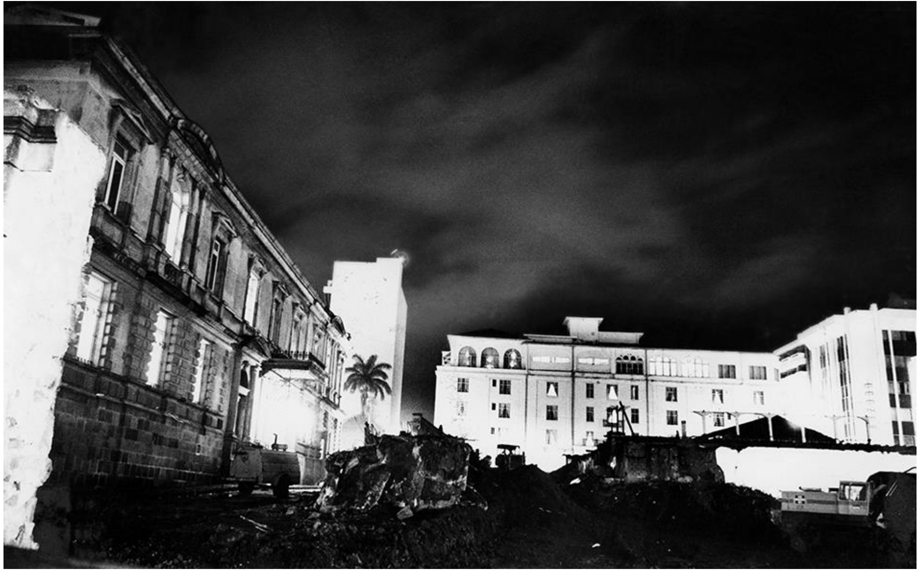
Mientras las obras avanzan, el 5º piso del Gran Hotel Costa Rica conserva las características descritas.
